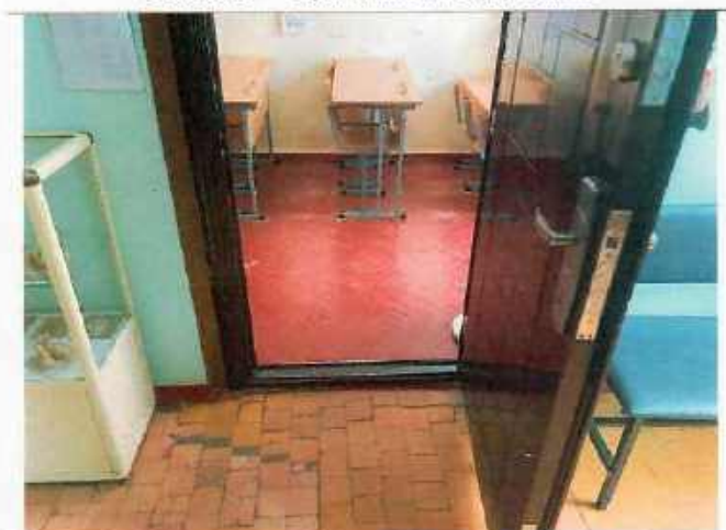
Фото № 15 – Пути движения внутри здания (двери).
