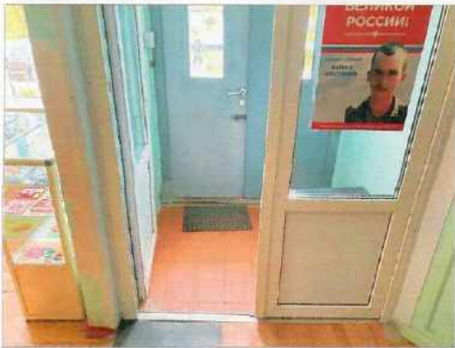
Фото № 9 – Внутренняя входная дверь. Тамбур.
