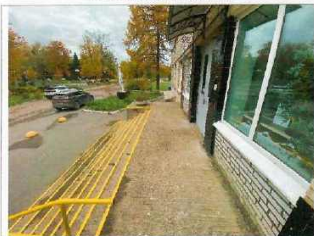
Фото № 4 – Входная площадка
