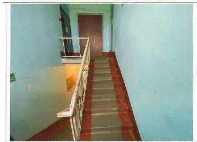
Фото № 12 – Пути движения внутри здания (лестница).
