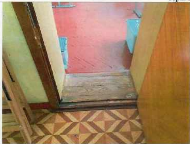
Фото №19 – Пути движения внутри здания (двери).
