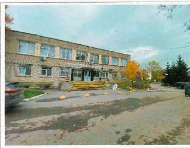
Фото № 2 – Подходы к объекту
