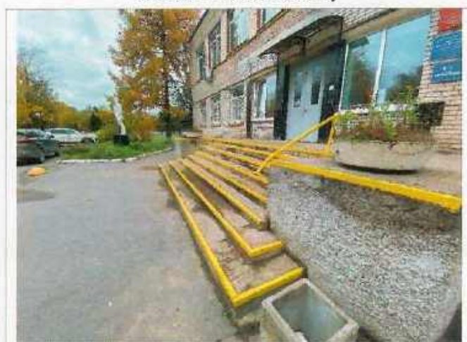
Фото № 3 – Наружная лестница. Выделенные ступени марша лестницы.
